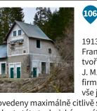
106 VODNÍ ELEKTRÁRNA POLKA Vodní elektrárna Polka u Horní Vltavice byla postavena v roce 1913 jako zdroj energie pro nedalekou Františkovu papírnu. Technické zařízení tvoří dvě Francisovy turbíny od firmy J. M. Voith, St. Polten a generátory od firmy Brown Boveri Wertke A.G. z Vídně, vše je dodnes plně funkční. Dosavadní opravy byly provedeny maximálně citlivě s důrazem na zachování estetické a historické hodnoty této technické památky.
